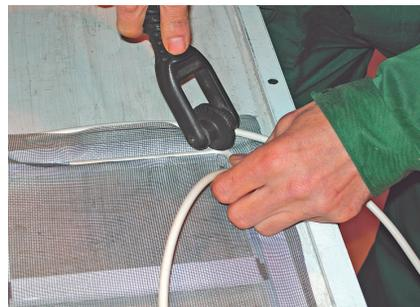
5. Закатать шнуром полотно москитной сетки в паз основного профиля с помощью закаточного ролика. При этом необходимо уделять особое внимание закатыванию шнура в углах москитной сетки.
